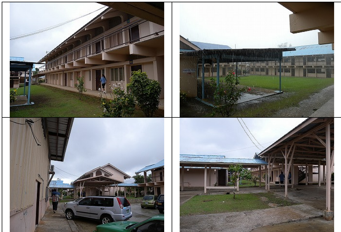
図 2.3-8 現地調査写真 (Palau High School)
