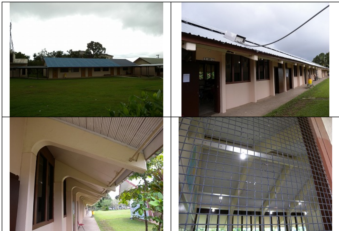
図 2.3-7 現地調査写真 (Koror Elementary School)
