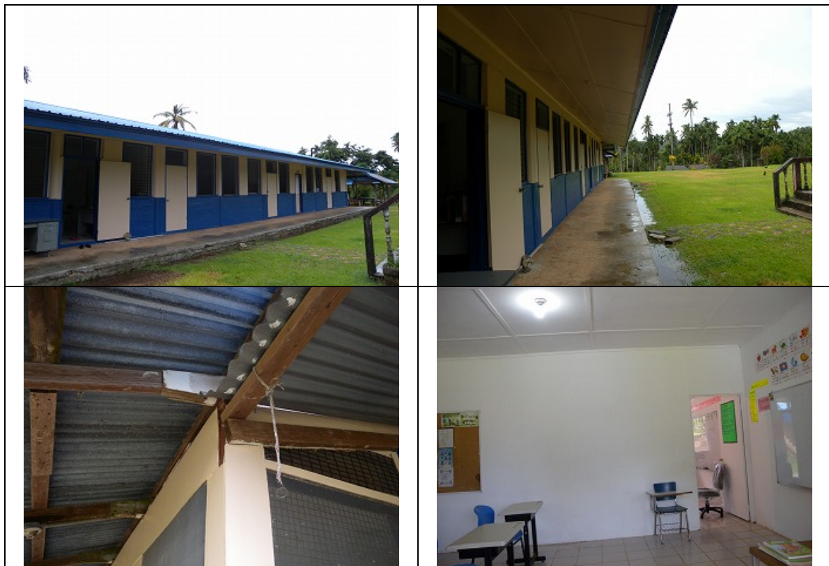
図 2.3-4 現地調査写真 (Ngardmau Elementary School)
