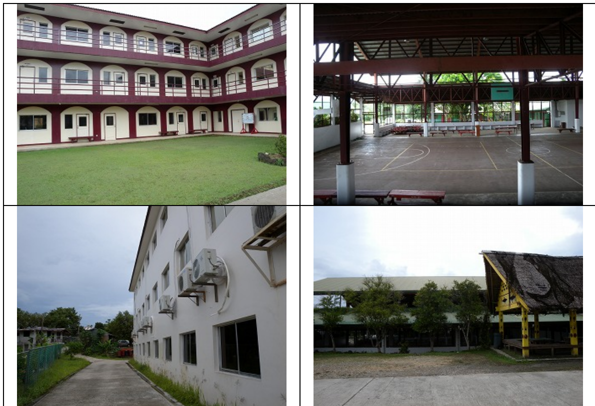
図 2.3-13 現地調査写真 (Mindszenty High School)
