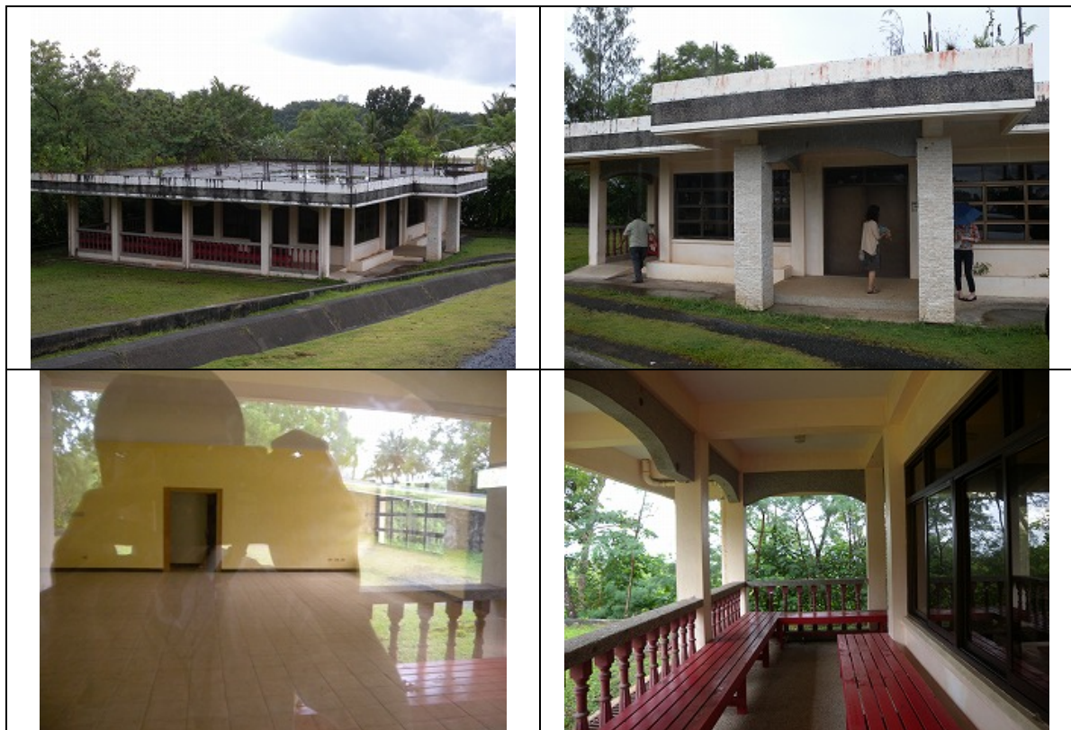
図 2.3-10 現地調査写真 (Oberaod Center)
