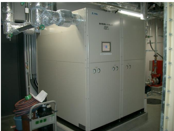
ヒートポンプ 本体
