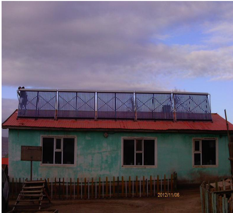
Дулааны хоолойт нарны вакуум коллектор Талбай: 40-120м 2
