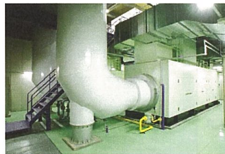
札幌駅南口エネルギーセンター ガスタービン発電機
