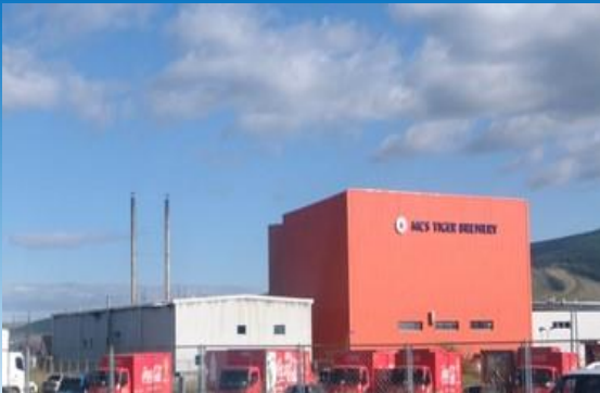
ヒートポンプ、蓄熱ヒーターの導入
