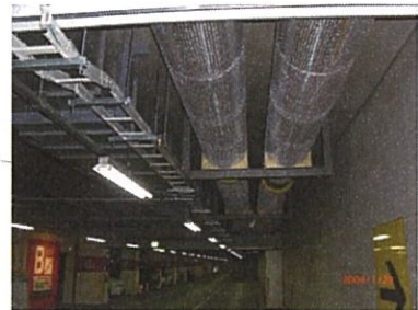
北一条地下駐車場内 冷水導管
