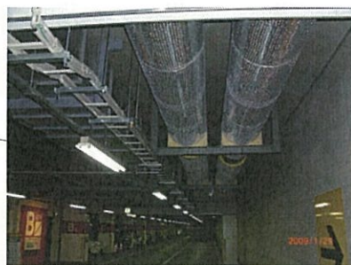
北一条地下駐車場内 冷水導管
