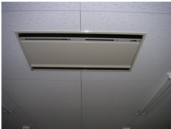
ファンコイル ユニット
