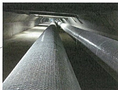
駅前通導管ピット内 冷水導管
