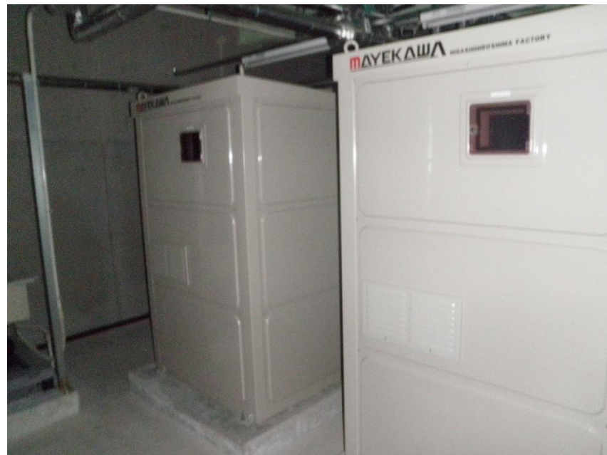
ヒートポンプ本体
