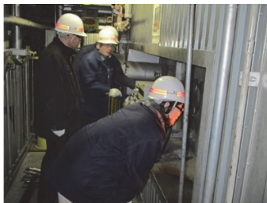
ボイラー燃焼部（日立造船製）
