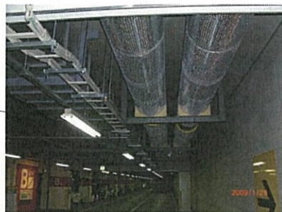
北一条地下駐車場内 冷水導管
