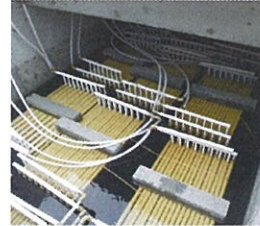
排湯槽と槽内の熱交換器の外観(東苗穂)
