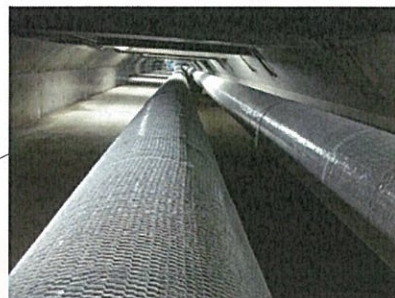
駅前通導管ピット内 冷水導管
