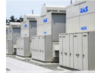
大容量蓄電池
