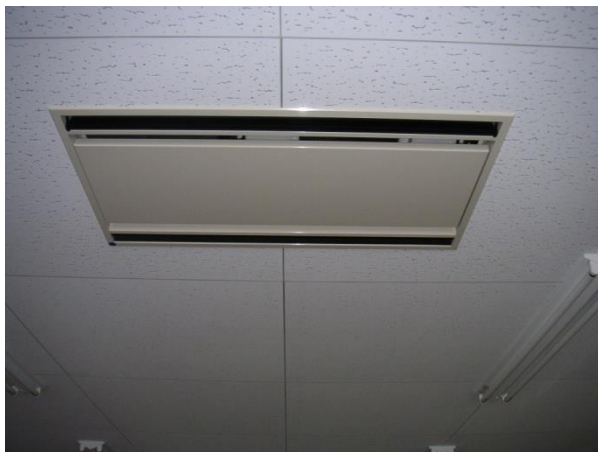
ファンコイル ユニット
