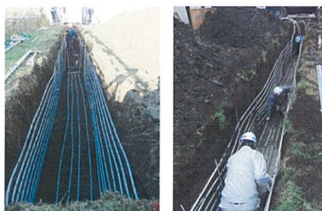
柵状熱交換器の施工
