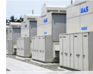
大容量蓄電池
