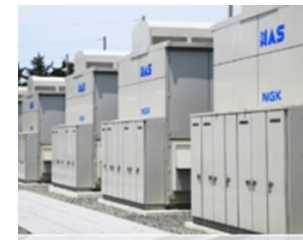
大容量蓄電池
