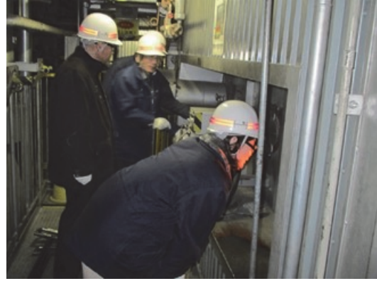
ボイラー燃焼部（日立造船製）
