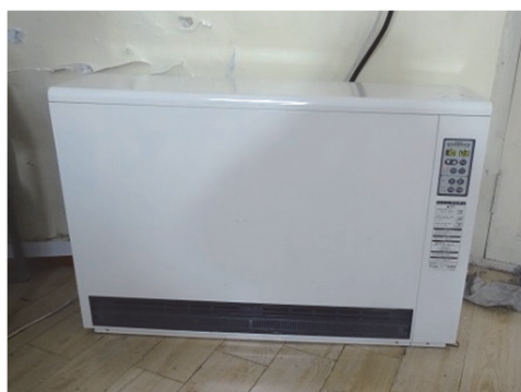
図 2-1 蓄熱ヒーター（熱容量 4kW）
