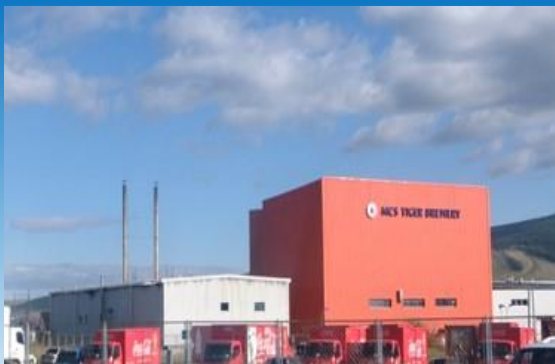
ヒートポンプ、蓄熱ヒーターの導入
