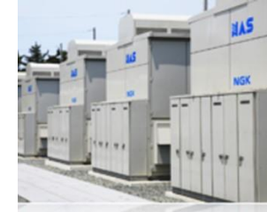
大容量蓄電池
