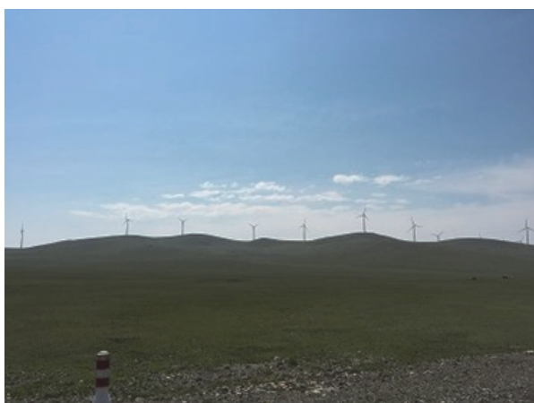
i) SWF(50MW)の遠景
