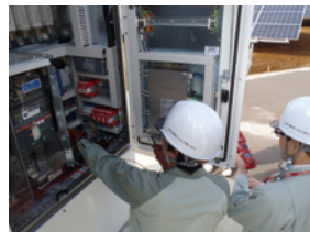
定期点検(性能診断)
