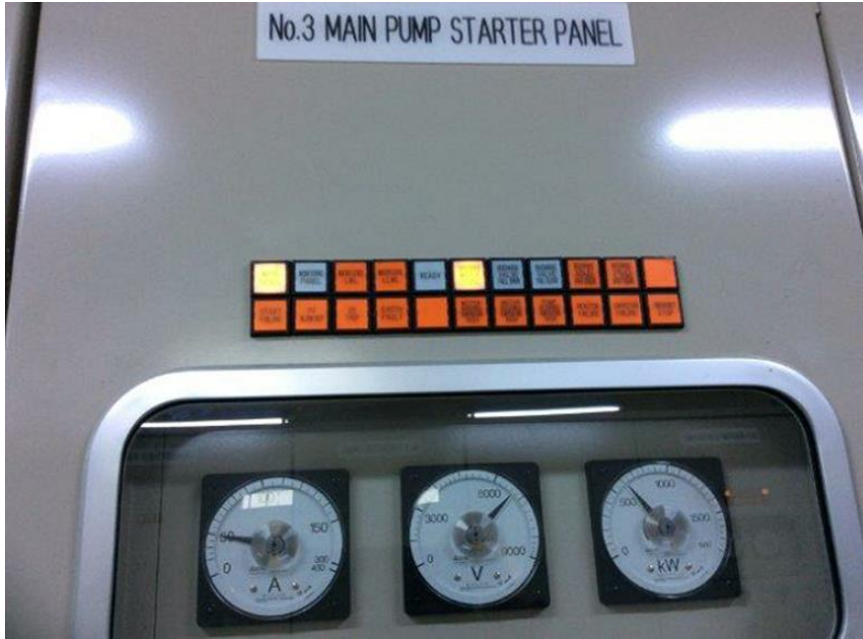
ポンプ起動盤
