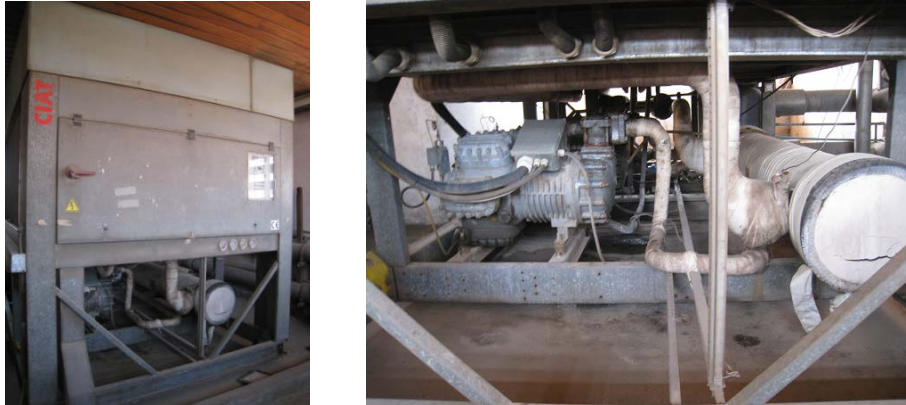
図表 3.2.2-4 既設の CIAT 製チラーシステム
