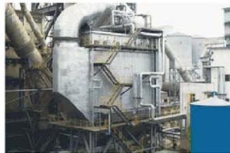
セメント工場廃熱回収発電設備の例
