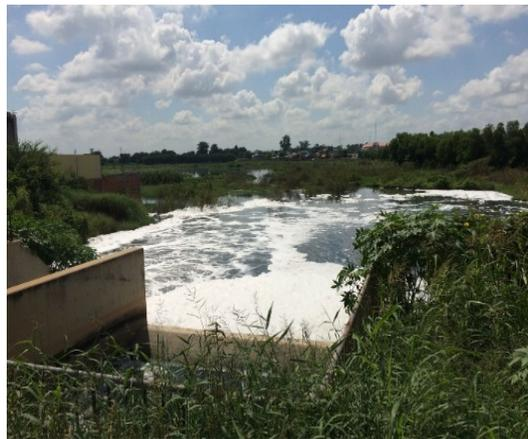
写真 2.4.6.1-2 安定化池への汚水排水状況
