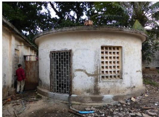
写真 2.4.5.2-4 同病院の汚水排水ポンプ室 設備故障のため仮設ポンプで排水
