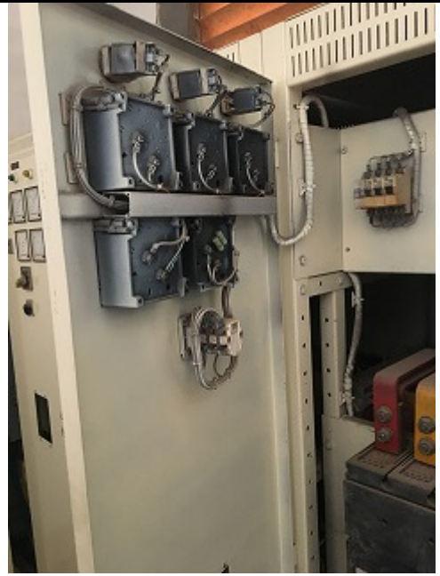
図 7.6 受電パネル内部
