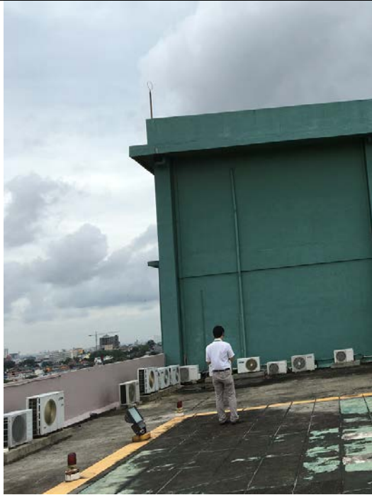
図 7.3 屋上にて室外機
