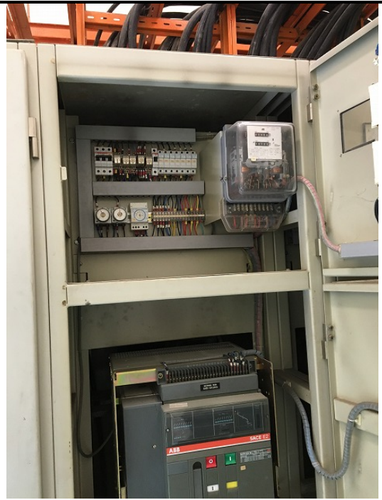
図 7.20 受電パネル内部
