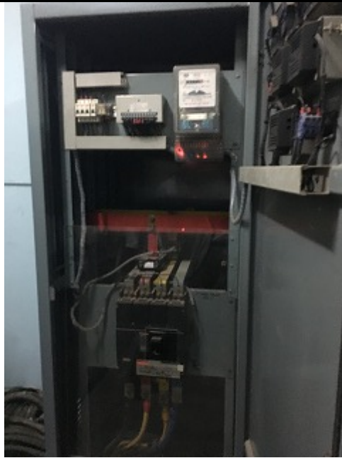
図 7.9 受電パネル内部
