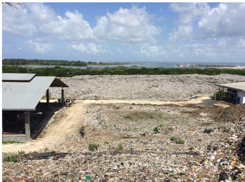
図 2.18 2016 年 7 月の様子（写真右側にガスエンジン建屋）
