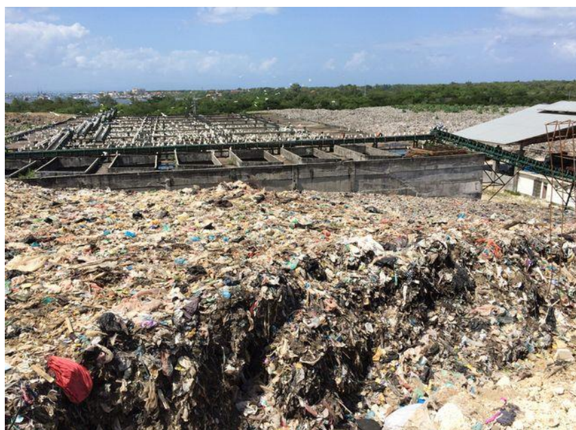
図 2.17 NOEI 社の設備 (メタン発酵槽らしきコンクリート槽)
