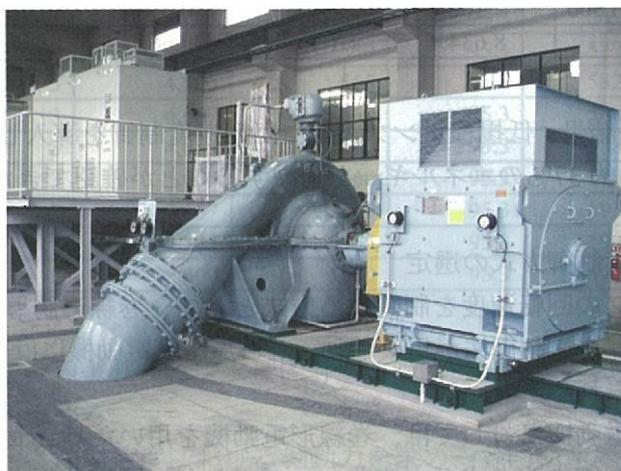
図 3-4 送水ポンプとインバータ装置の例
