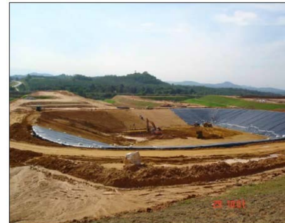
図2 KA社最終処分場（処分容量：10～12万トン/区画）
