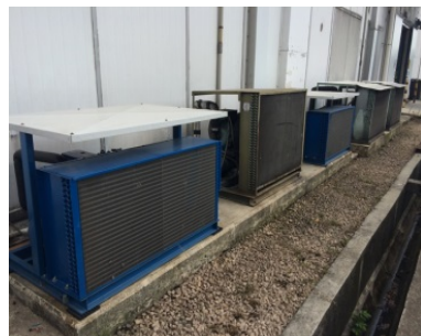
屋外に設置されている圧縮機 (6月の現地調査にて撮影)
