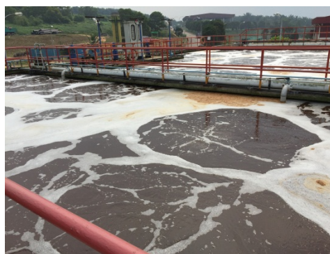
排水処理槽(曝気処理)
