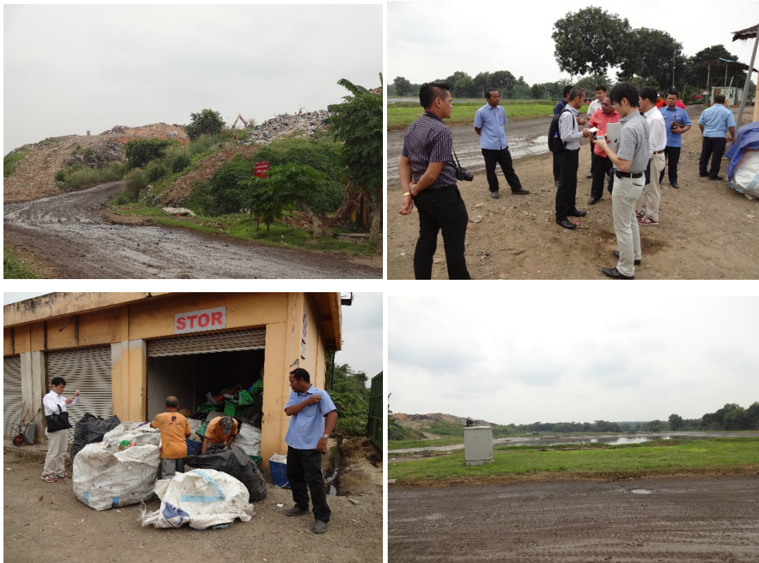
Photos of Tanjung Langsat Landfill
