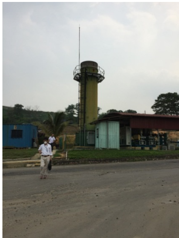
処分場から回収するメタンの燃焼設備 (現在ガスエンジンを据え付け中)
