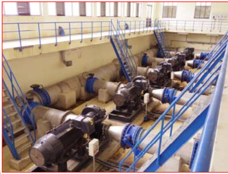
TRẠM BƠM CẤP II CẦU ĐÒ
