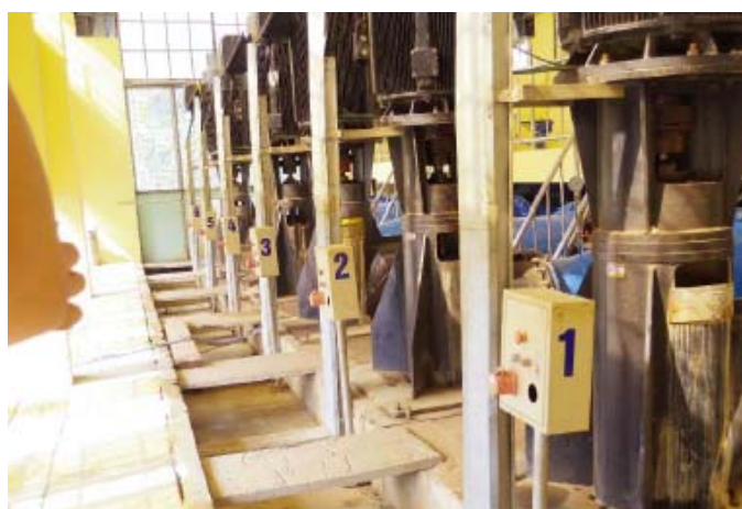
(写真 4-26: アンチャ浄水場のポンプ)
