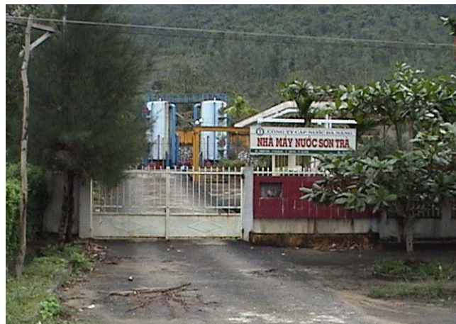
(写真 4-20: ソントラ浄水場)
