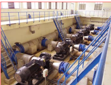
TRẠM BƠM CẤP II CẦU ĐỒ
