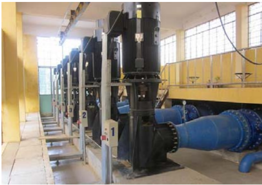
(写真 4-18: アンチャ ポンプ場のポンプ )
