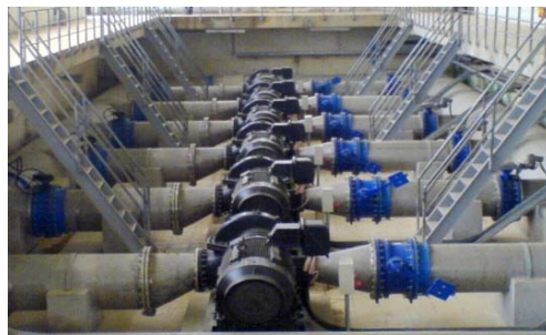
(写真 4-9:カウドウ Level 2 Pump Station における原水ポンプ)
