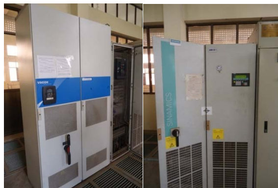
(写真 4-10:カウドウ 給水ポンプに付設されているインバーター) (フィンランド VACON 社製)
