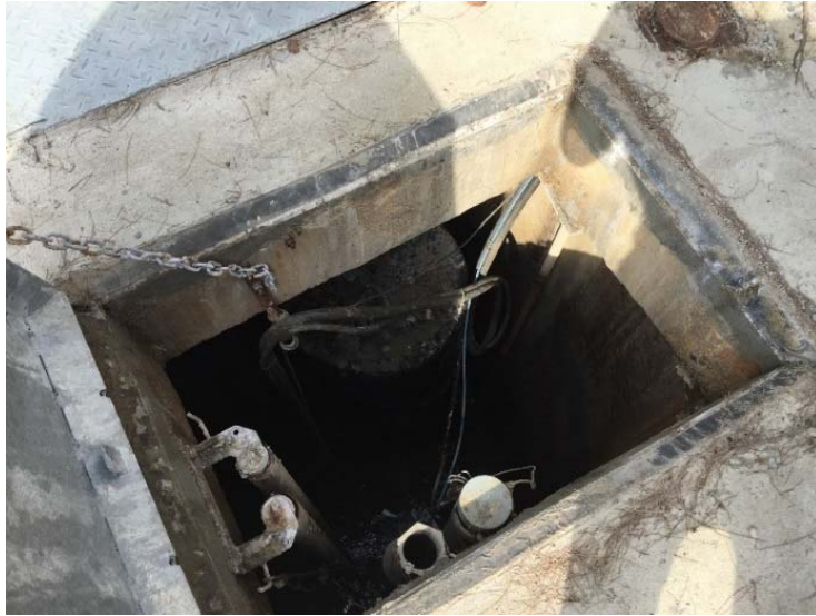
(写真 4-42: 新市街地のポンプ設置場所)
