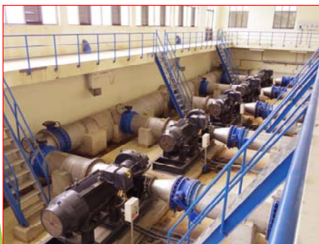
TRẠM BƠM CẤP II CẦU ĐỒ
