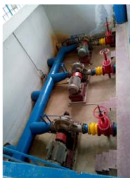
(写真 4-5:古カウドゥ Level 1 Pump Station における原水ポンプ)
