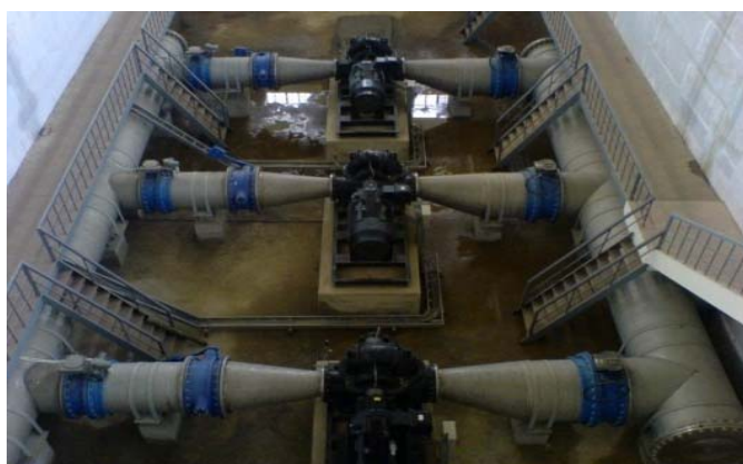
(写真 4-6:新カウドウ Level 1 Pump Station における原水ポンプ)
