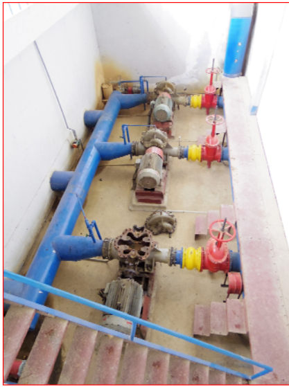
TRẠM BƠM CẤP I CẦU ĐÒ CŨ
