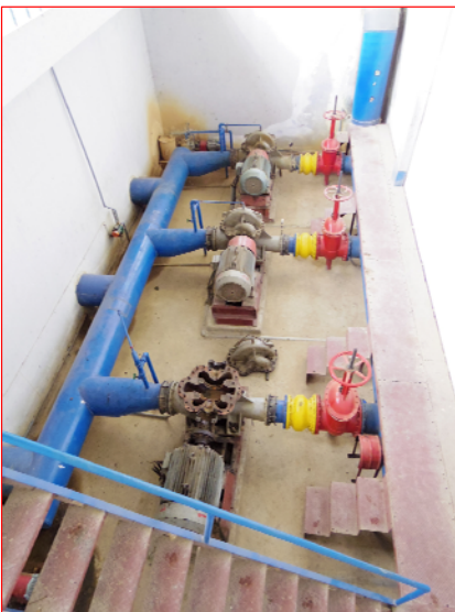
TRẠM BƠM CẤP I CẦU ĐÒ CŨ
