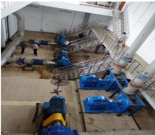
(写真 4-14:新サンベイ Level2 ポンプ)
