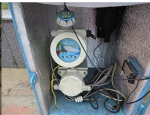
(写真 4-13: 古系統の給水流量表示)
