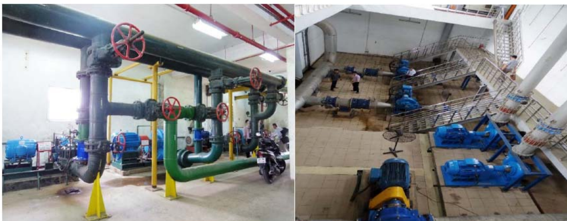
(写真 4-25:サンベイ浄水場のポンプ)
