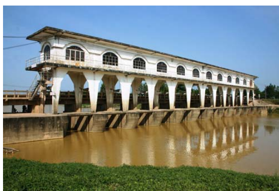
(写真 4-17:エン川からの取水堰)
