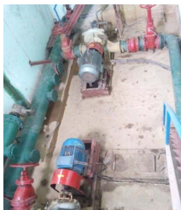
(写真 4-7:古サンベイ Level 1 Pump Station における原水ポンプ)
