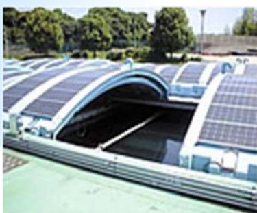
小雀浄水場ろ過池 太陽光発電設備
