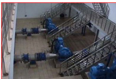
TRẠM BƠM CẤP II SÂN BAY
