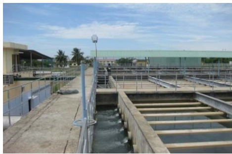
(写真 4-1:カウドウ浄水場の LAMELLA SEDIMENTATION)
