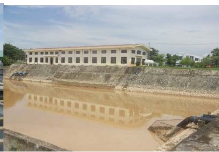
(写真 4-2:カウドウ浄水場の原水池)
