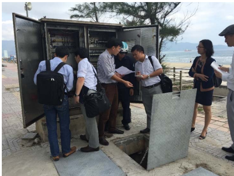
(写真 4-43: ポンプの配電盤の視察)
