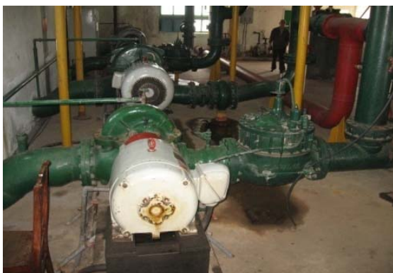
(写真 4-12 : 古サンベイ Level 2 ポンプ)
