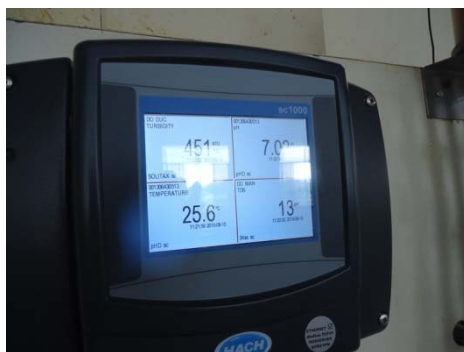
(写真 4-3: 取水の水質モニター)
