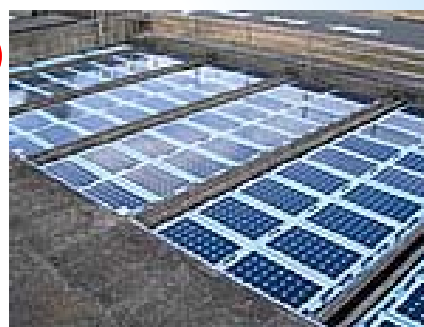
小雀浄水場沈殿池 太陽光発電設備
