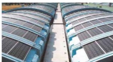
ろ過池上部に設置された可動式太陽光発電設備(小雀浄水場)
