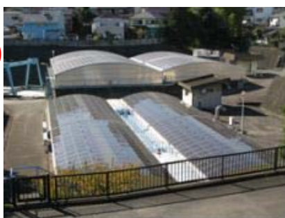
西谷浄水場排水処理施設 太陽光発電設備
