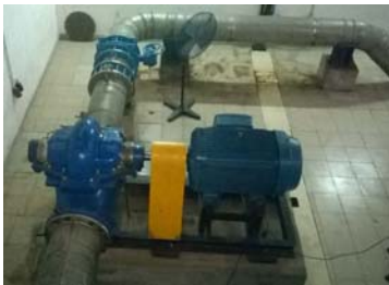
TRẠM BƠM CẤP II SÂN BAY
