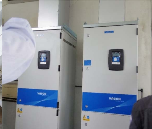
(写真 4-15:付設されているインバーター (フィンランド VACON 社製))
