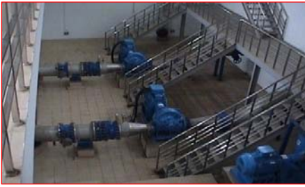
TRẠM BƠM CẤP II SÂN BAY
