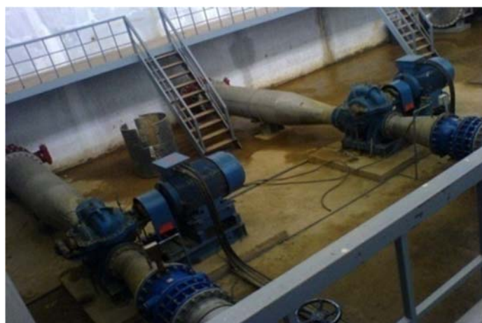
(写真 4-8: 新サンベイ Level 1 Pump Stationにおける原水ポンプ)
