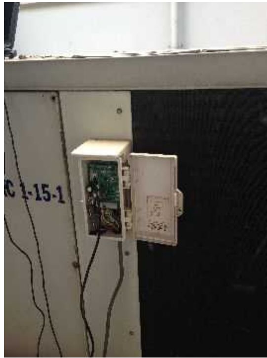
写真 3.1.4 室外機に設置した Be One
