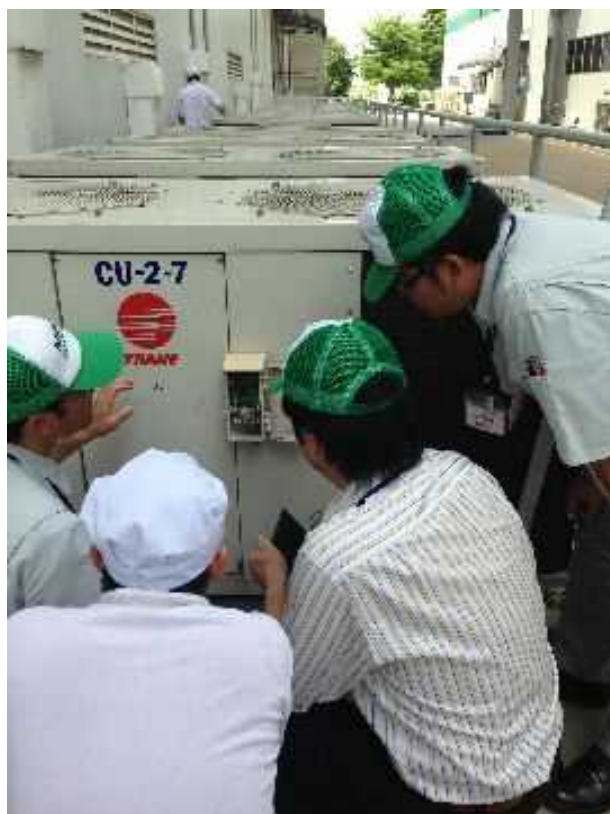
写真 3.1.7 Be One の設置状況を確認する様子
