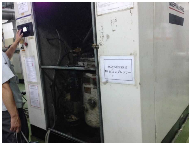
写真 3.1.5 コンプレッサーの稼働状況を確認する様子
