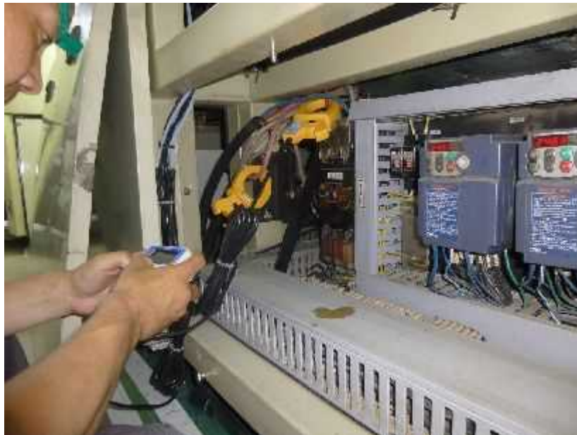
写真 3.1.6 コンプレッサーの圧力を確認する様子
