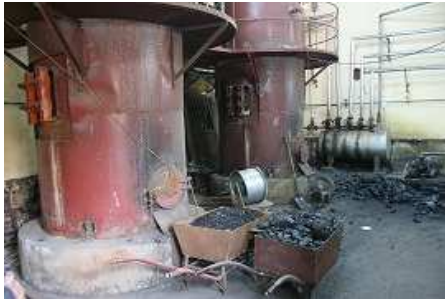
写真 1.3.6 病院の石炭焼きボイラー
