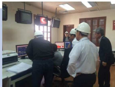
中央制御室にて運用確認
