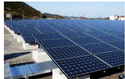
写真 1.3.8 北九州市・太陽光発電所
