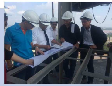
図面と現場の照会
