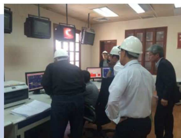
中央制御室でのデータ 調査による現状の確認
