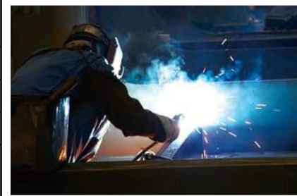
写真 鋼板の溶接作業
