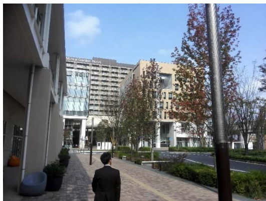
エネルギー棟(蓄電池等が設置されている)
