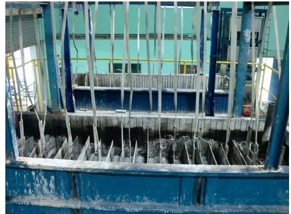
既存の工業排水処理機器
