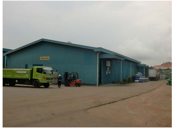
工場屋上(太陽光パネルの設置検討対象)
