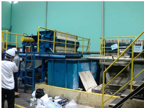
既存の工業排水処理機器(ベルトプレス)
