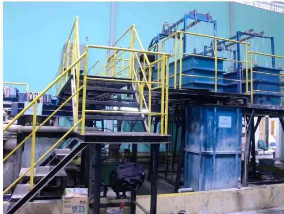
既存の工業排水処理機器
