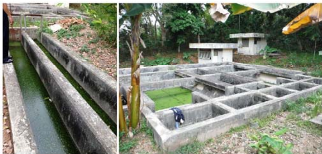
【再エネ】汚水処理がされていない
