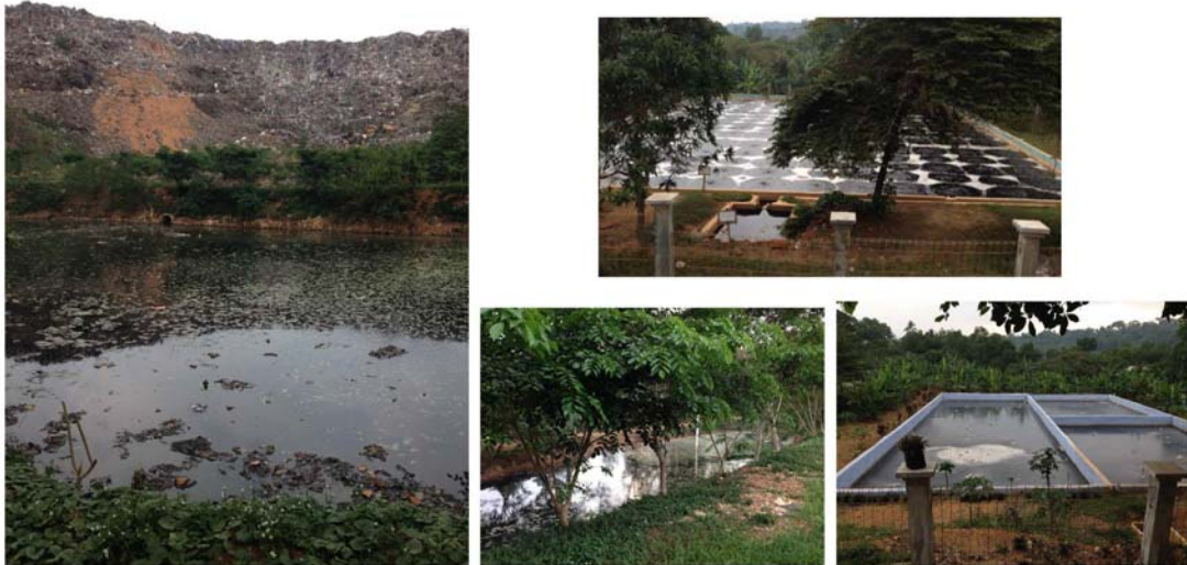
【再エネ・省エネ】廃棄物管理，浸出水処理が不十分
