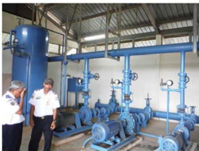
【省エネ】上水供給ポンプの効率が悪い (現地の日系等の工場にも可能性あり)
