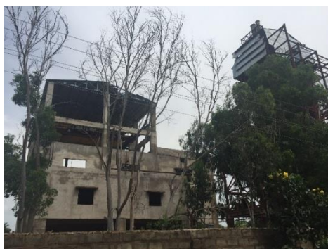
図 3-13 : 建設途中で野ざらしにされた民間企業の廃棄物焼却発電施設
