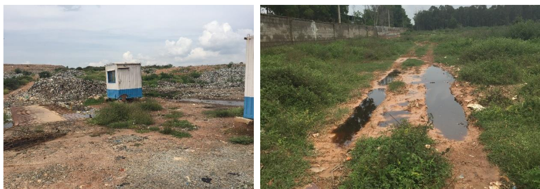
図 3-7：閉鎖された Mandur 処分場と敷地周辺に染み出した浸出水
