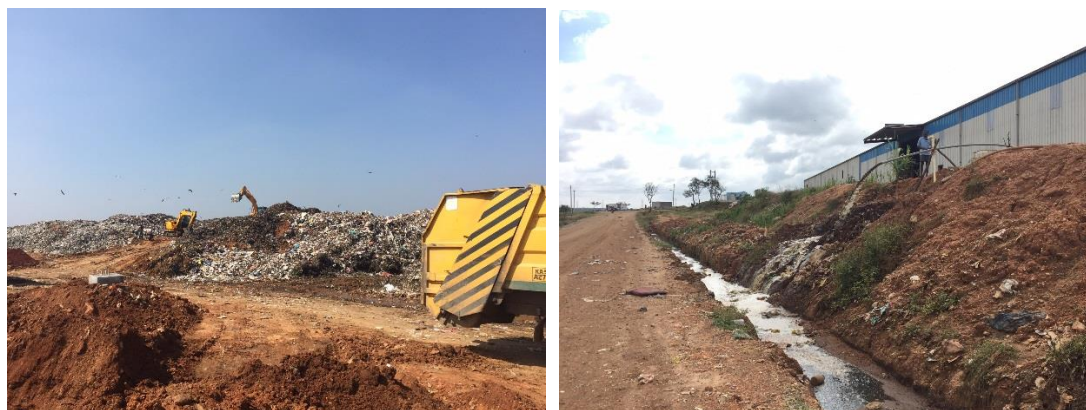
図 3-8 : オープンダンプングの様子 (左) と未処理の浸出水が捨てられている様子 (右)
