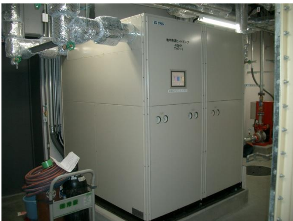
ヒートポンプ 本体
