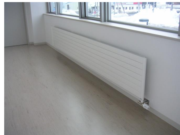
温水パネル ヒーター
