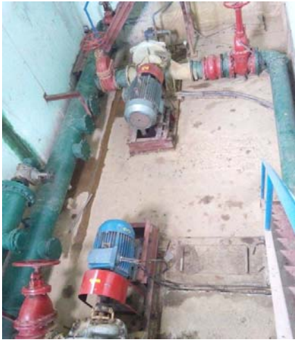
TRẠM CẤP I SÂN BAY CŨ
