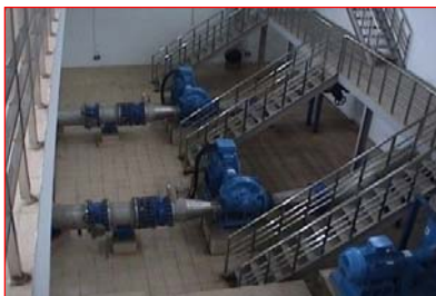
TRẠM BƠM CẤP II SÂN BAY
