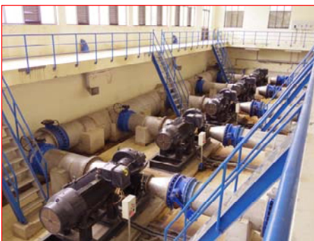
TRẠM BƠM CẤP II CẦU ĐỒ
