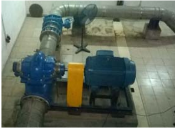
TRẠM BƠM CẤP II SÂN BAY
