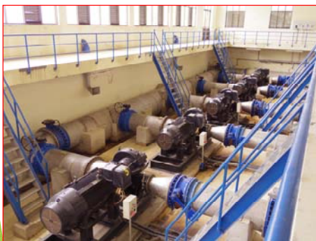
TRẠM BƠM CẤP II CẦU ĐỒ
