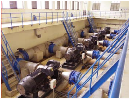
TRẠM BƠM CẤP II CẦU ĐỒ
