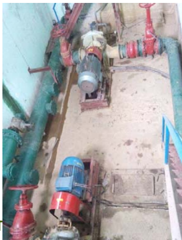
TRẠM CẤP I SÂN BAY CŨ
