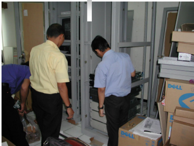
インドネシア環境省では新しいウェブサーバの設置作業が行われていた
