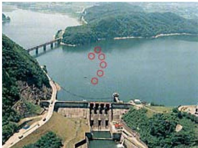
写真 8-5-2 釜房ダム貯水池の曝気筒の位置
