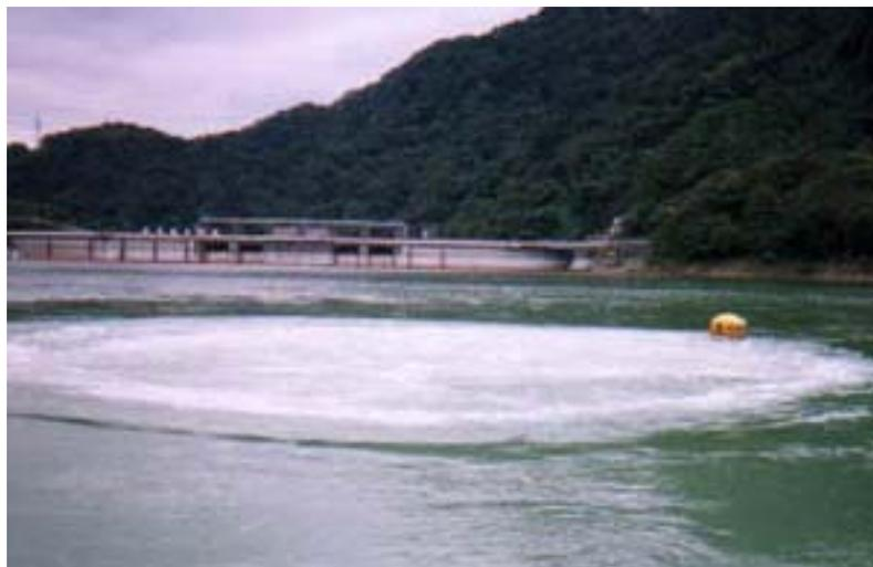
写真 8-5-1 ばっ気筒による噴流状況
