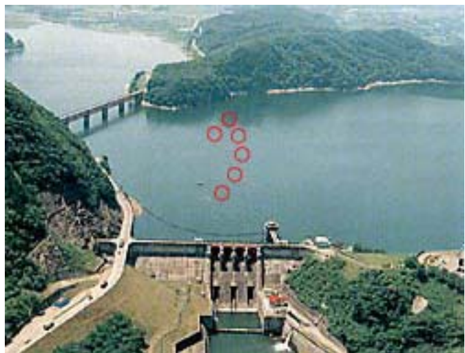
写真 8-5-2 釜房ダム貯水池の曝気筒の位置
