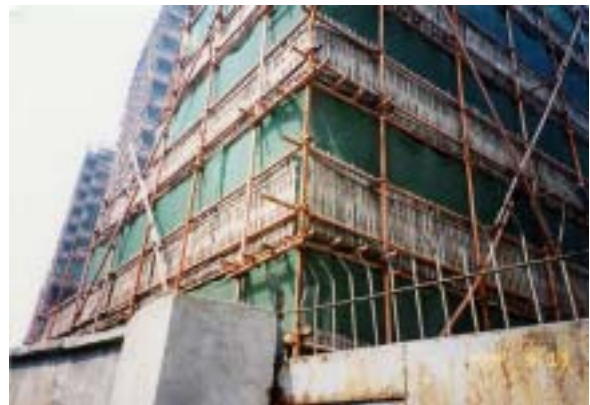
写真 8-4-8 竹を活用している中国の建設現場
