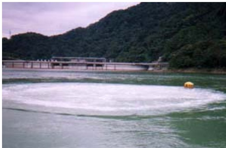
写真 8-5-1 ばっ気筒による噴流状況
