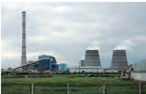
第4火力発電所
