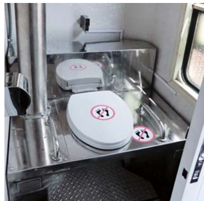
車両内に設置されたバイオトイレ
