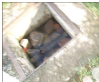
ハヤタバッド工業地帯下流の下水処理場 沈殿池として機能しているのみである。沈殿池からはメタンが発生し、辺り一帯は悪臭が漂っていた。ペシャワール市は、本施設の改修予定はなく、さらに下流に処理場を新設する計画である。本処理場は埋立て住宅団地を造成予定である。
