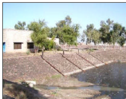
ハヤタバッド工業地帯下流の下水処理場 沈殿池として機能しているのみである。沈殿池からはメタンが発生し、辺り一帯は悪臭が漂っていた。ペシャワール市は、本施設の改修予定はなく、さらに下流に処理場を新設する計画である。本処理場は埋立て住宅団地を造成予定である。
