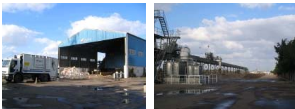
写真 5.22: アレキサンドリアのコンポストプラント
