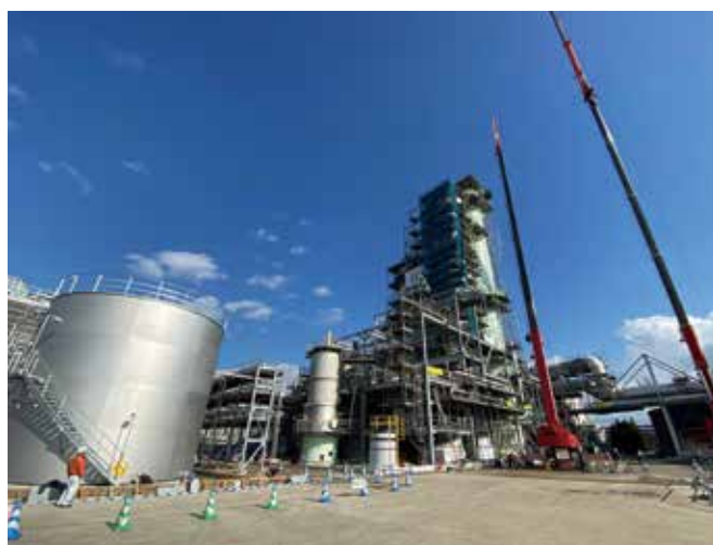
建設中のCO 2 分離・回収実証設備(2020年1月末現在)
