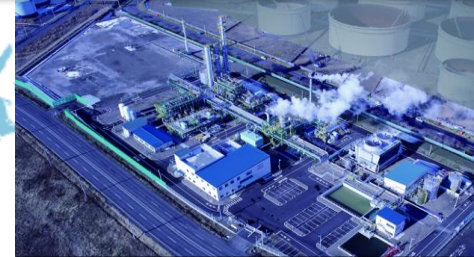
苫小牧CCS実証試験
