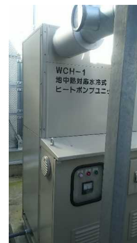
地中熱ヒートポンプ ユニット
