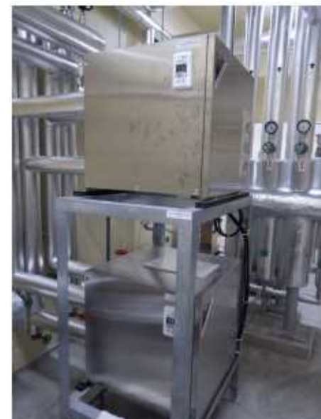
地中熱ヒートポンプ
