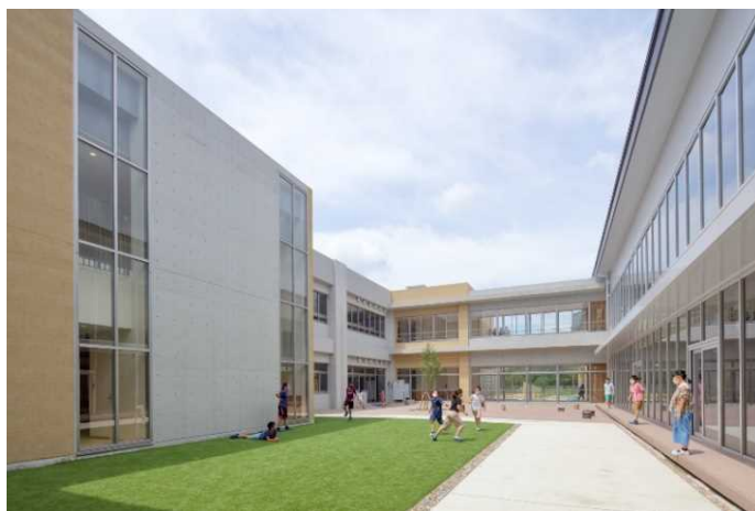
建物中庭（自然採光・Low-Eガラス）
