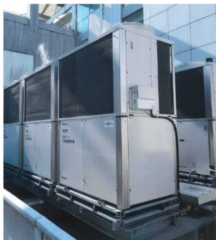
高効率空調設備（室外機）
