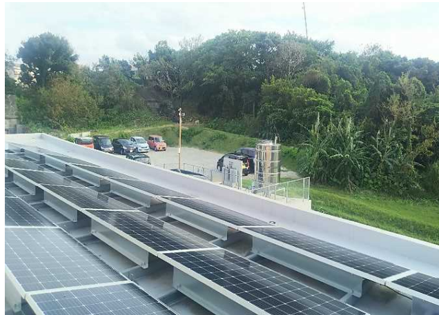
太陽光発電システム
