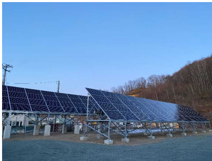
太陽光発電システム
