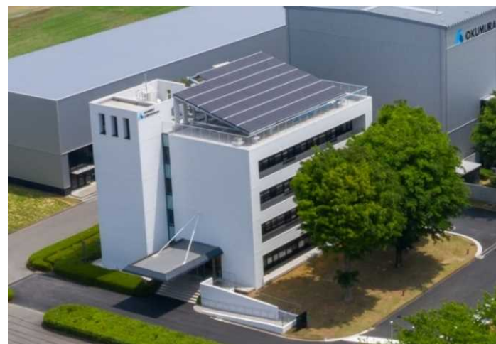
対象施設の外観 (技術研究所管理棟)
