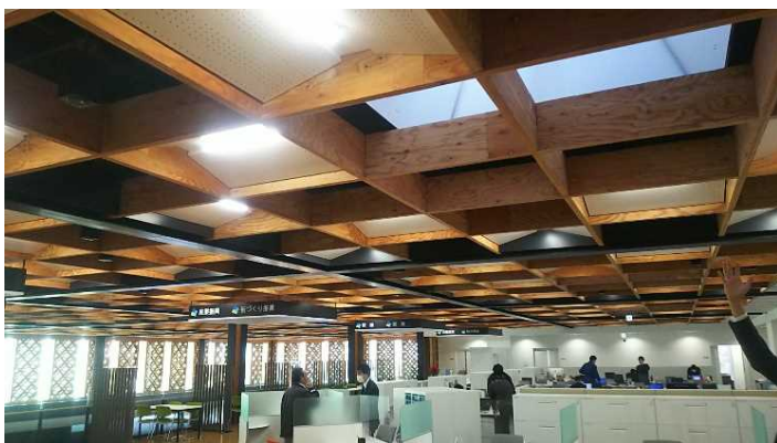
執務室の様子（LED照明、自然採光システム、窓枠の木材格子）
