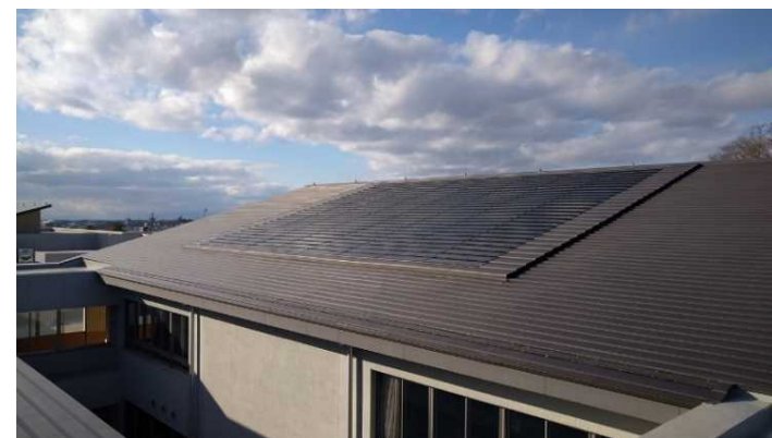
太陽光パネル（20kW）
