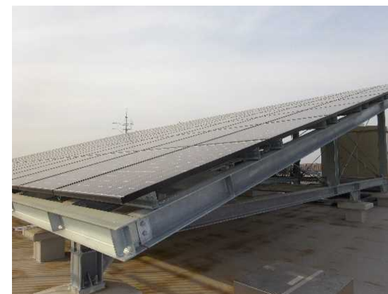
太陽光発電システム(32.5kW)
