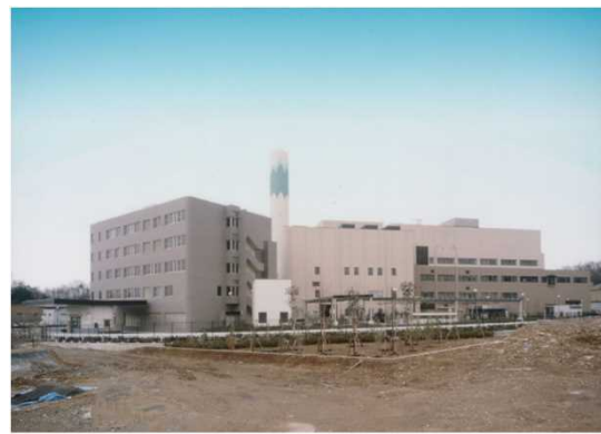
戸吹清掃工場
