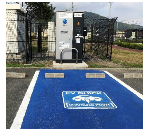
EV急速充電器
