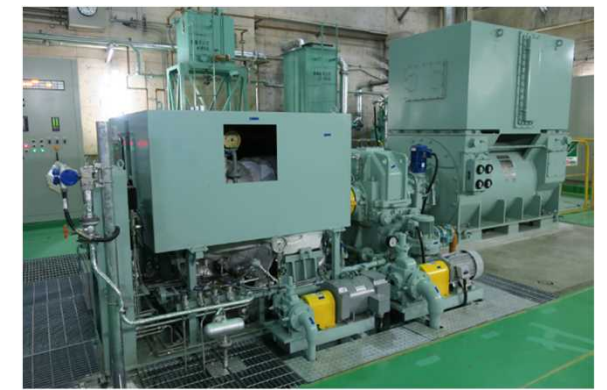
蒸気タービン発電機
