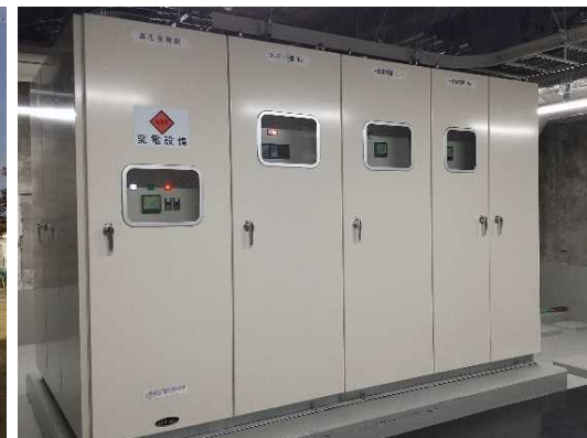
補助対象設備 (受変電設備)
