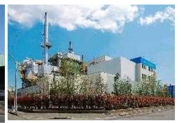
焼却熱回収発電システム (設備本体)
