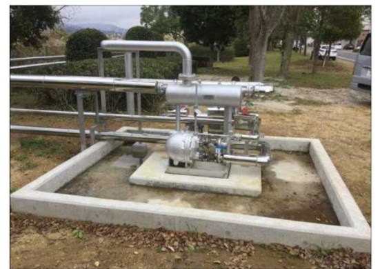
ドレン回収装置
