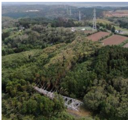
<鉄塔の倒壊（君津市）>
