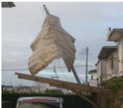
<飛来物による電柱倒壊（東金市）>
