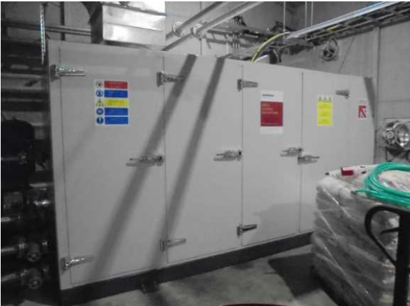
バイオガス発電機
