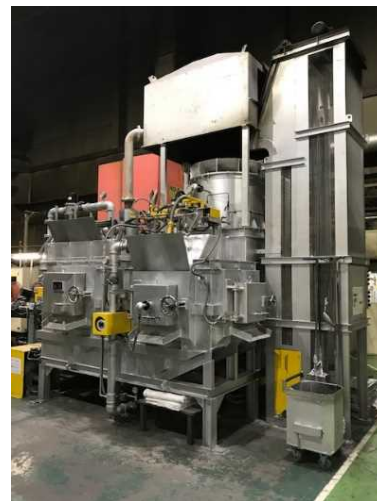
高効率燃焼式工業炉 (設備本体)
