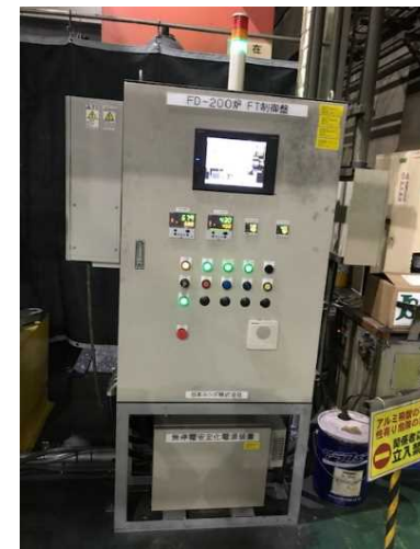
高効率燃焼式工業炉 (制御盤)
