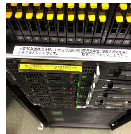
システムサーバー②
