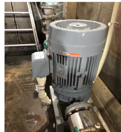
不凍液循環ポンプ
