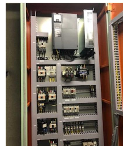
インバータ制御装置 (左: 外観、右: 機器内部)
