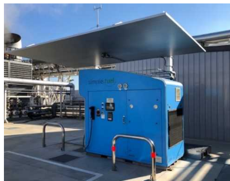
水素ステーション
