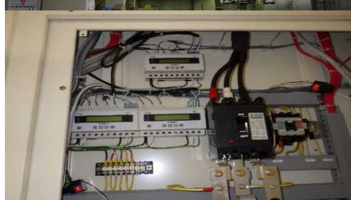
照明・電力計測器
