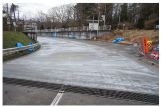
南原陸橋北側 軽井沢町離山 (コンクリート打設/完了)
