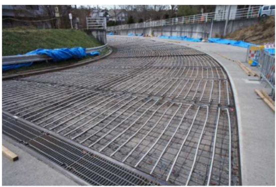
南原陸橋北側 軽井沢町離山 (ヒートパイプ設置/加工時)
