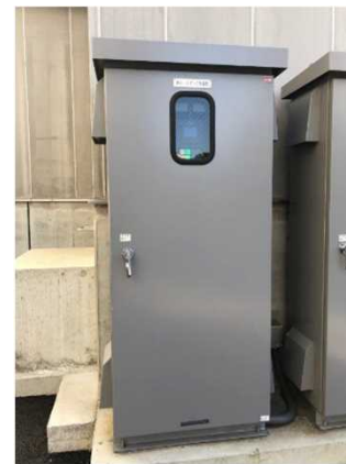
井水ポンプ制御盤
