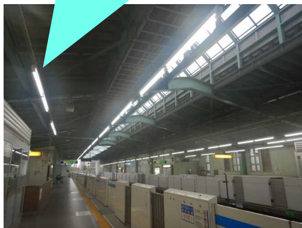
直管型LED照明 (仲町台駅ホーム 高架式)
