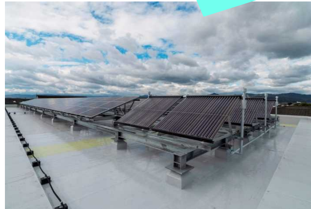
太陽光発電設備・太陽熱利用システム
