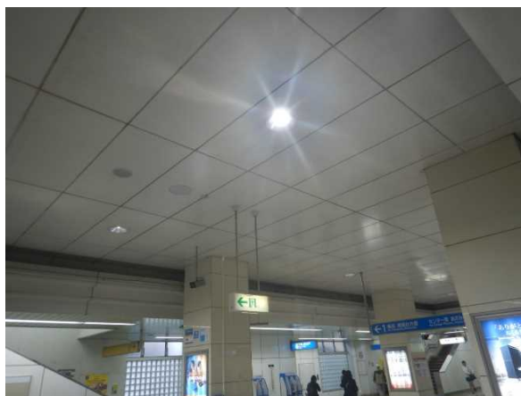
ダウンライトLED照明 (仲町台駅ホーム)
