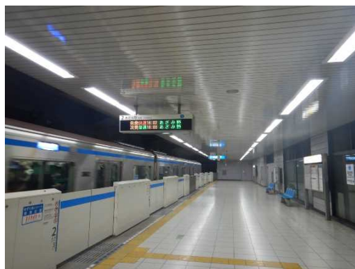
LED照明（中川駅ホーム）
