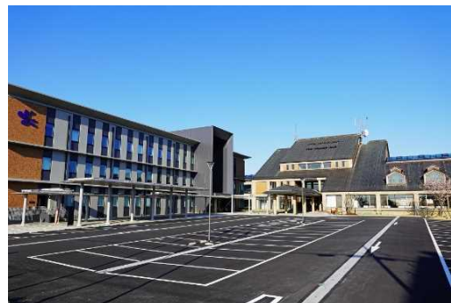
建物外観（左:新館、右:本館）
