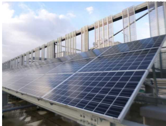
太陽光発電システム(10kW)
