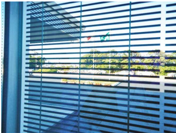
壁面の発電ガラス（建物内側より）
