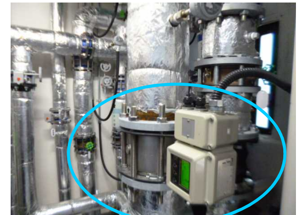
井水汲み上げポンプ
