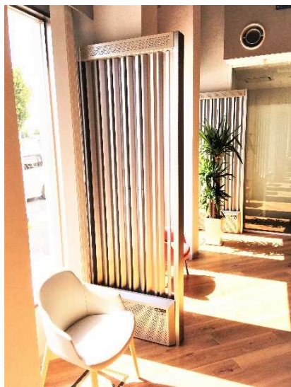
輻射式冷暖房システム
