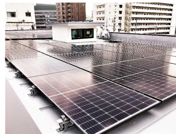
太陽光パネル（屋上）
