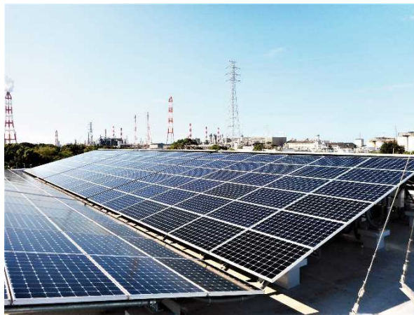
屋上の太陽光発電
