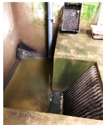
旧浄化槽の流入槽手前の粗目スクリーンを再利用
