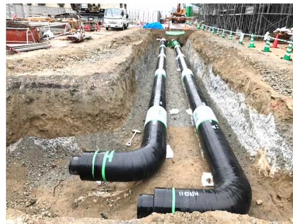
埋設温水管の様子 (出所：廿日市市提供)
