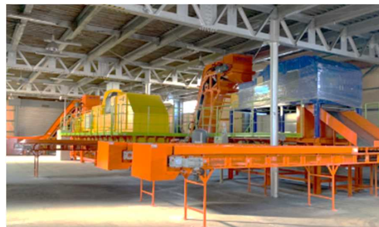
導入設備全景
