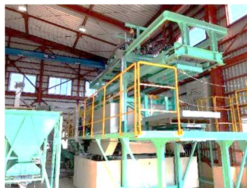
導入設備 (フレーム分解部)
