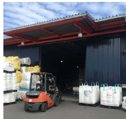
高松工場外観
