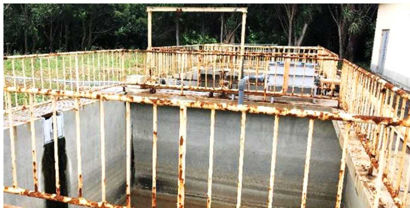
不明水対策用水槽（旧浄化槽の流量調整槽3槽）
