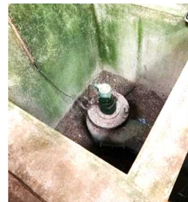
旧浄化槽の流入槽手前の破砕機を再利用
