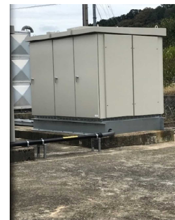
キュービクル (電源設備)
