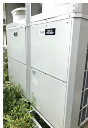
高効率パッケージエアコン (空調室外機)
