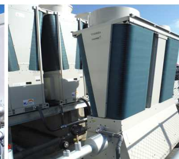
高効率ヒートポンプ給湯器 (給湯)
