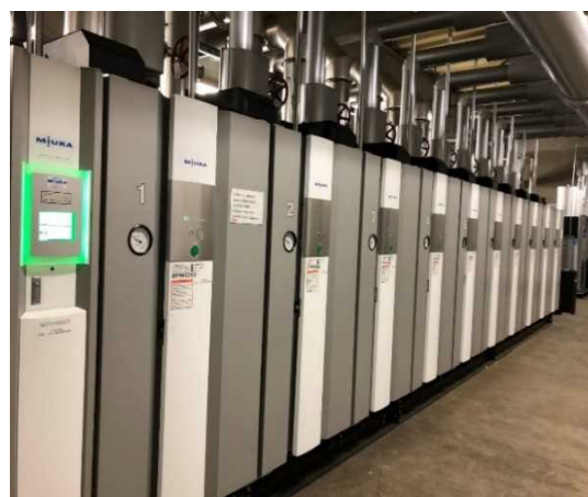
LPG焼き高効率ボイラー
