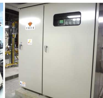
高効率キュービクル (受変電)
