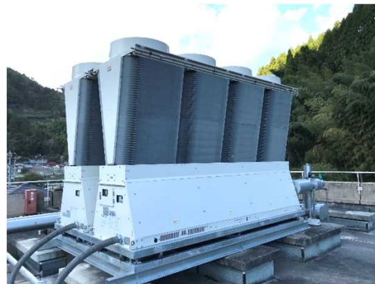
空冷ヒートポンプチラー (空調機)
