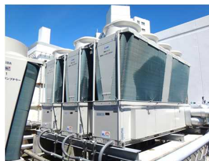
空冷ヒートポンプチラー (空調)
