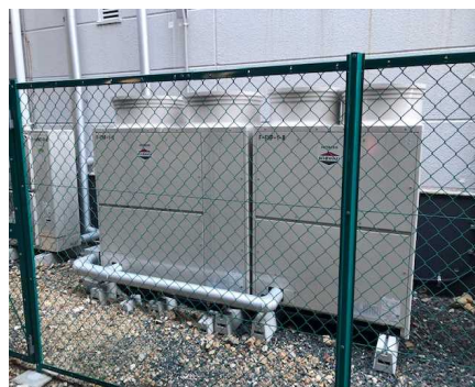
マルチエアコン (室外機)
