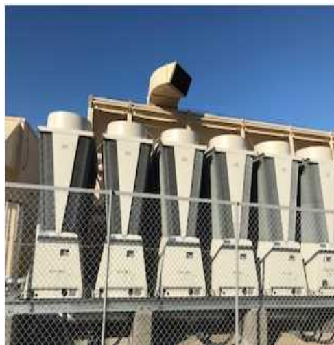
空冷ヒートポンプ式チラー (空調機)
