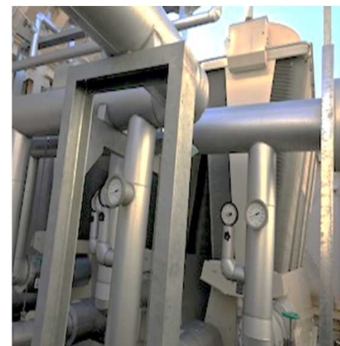
空冷ヒートポンプ式チラー (空調機)
