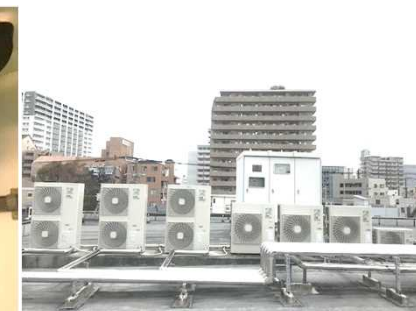
高効率空調設備（室外機）
