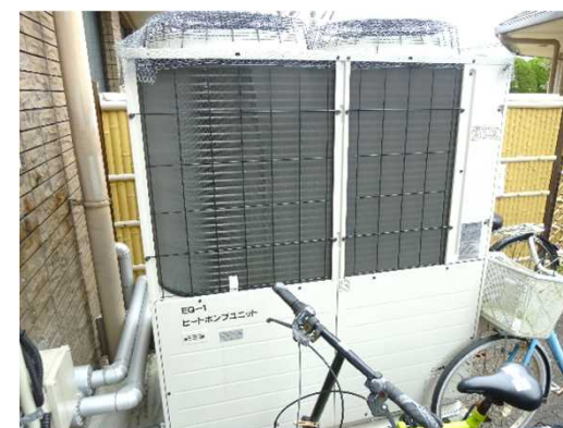
ヒートポンプ給湯器 (室外機)
