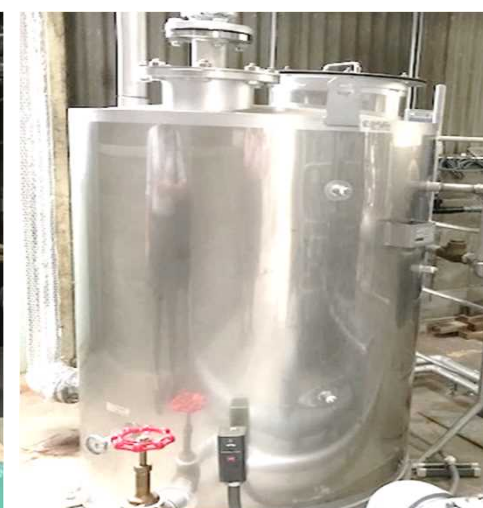
ボイラーの蒸気発生用 給水タンク
