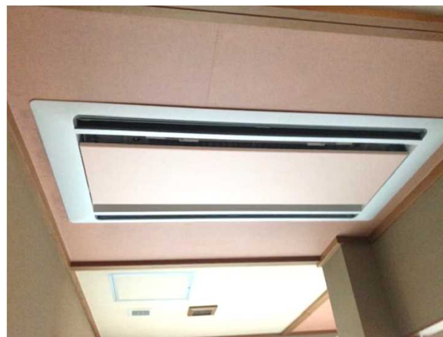
高効率ヒートポンプ空調 (室内機)
