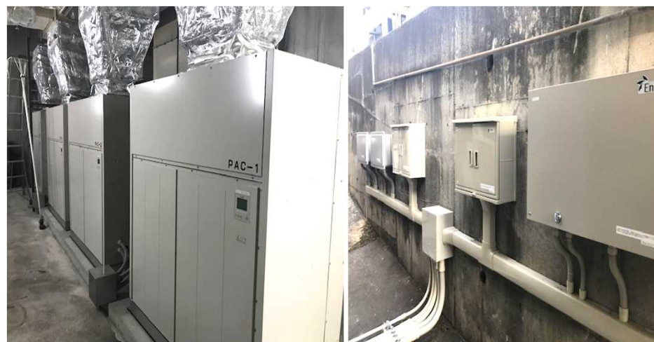
高効率空調 (室外機)
