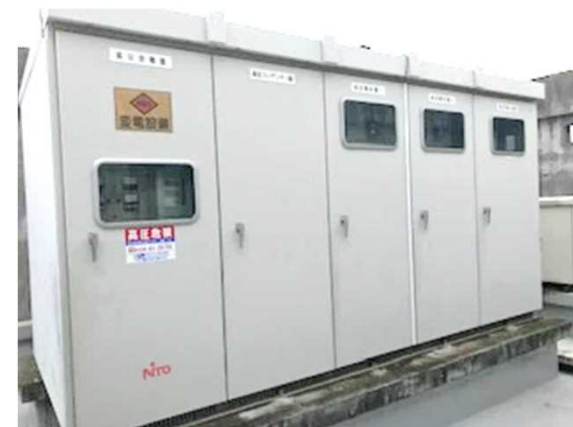
高効率キュービクル (受変電設備)
