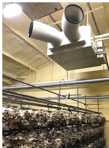
高効率空調機(冷房)
