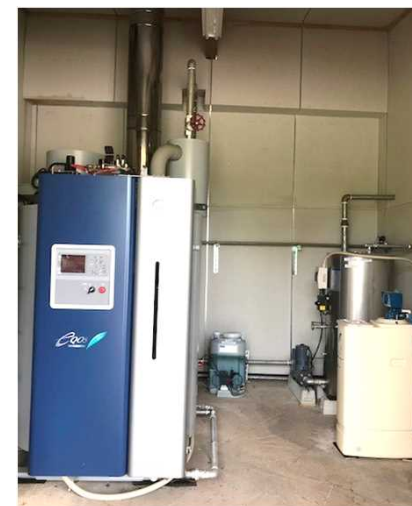
高効率灯油焚きボイラー(暖房)
