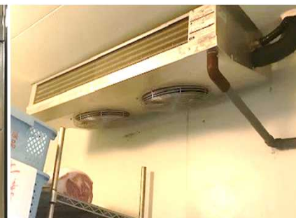
高効率空調設備（室内機）
