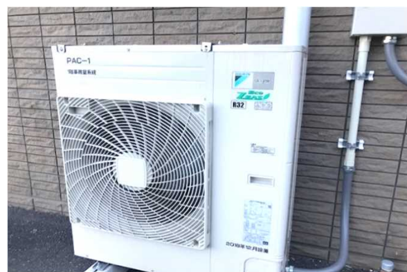
ビル用マルチエアコン (室外機)
