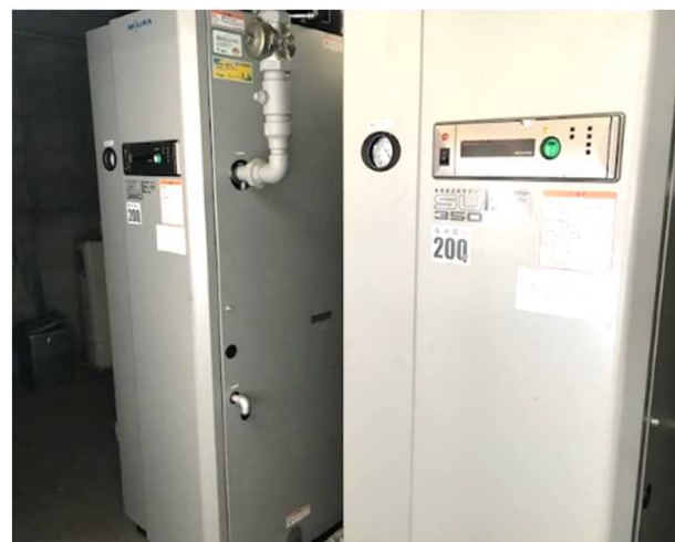
高効率都市ガス焚きボイラー
