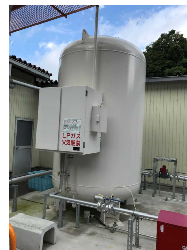
LPGサテライト設備 (燃料供給設備)
