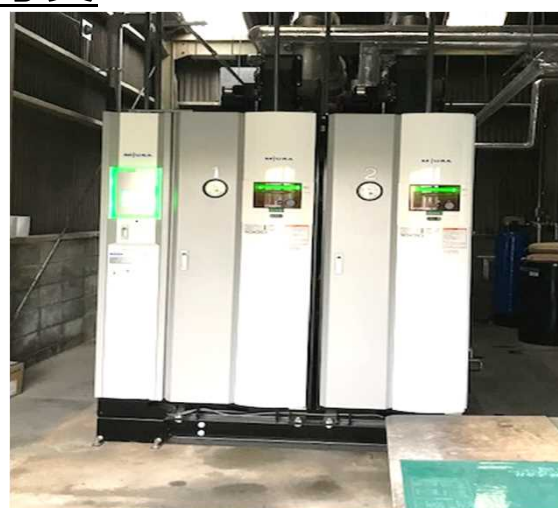
都市ガス焚きボイラー (台数制御装置内蔵)
