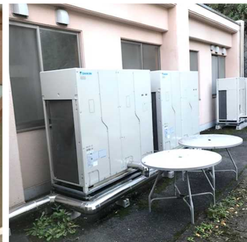
高効率ヒートポンプ空調 (室外機)
