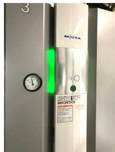
LPG焚き高効率ボイラー
