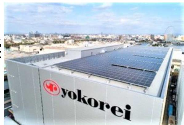
屋上に設置した太陽光発電装置 (351 kW)
