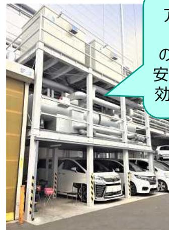
NH<sub>3</sub>/CO<sub>2</sub>冷凍機とCO<sub>2</sub>レシーバ・ポンプユニット
