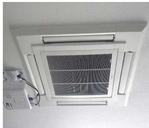
会議室(室内機)
