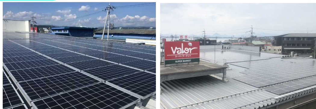
【写真2・3】グループ他店舗の太陽光発電設備
