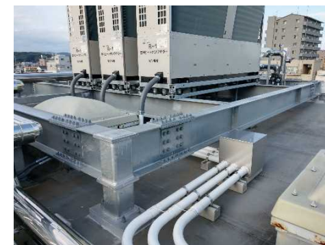
従来設備の冷却塔 足場を活用
