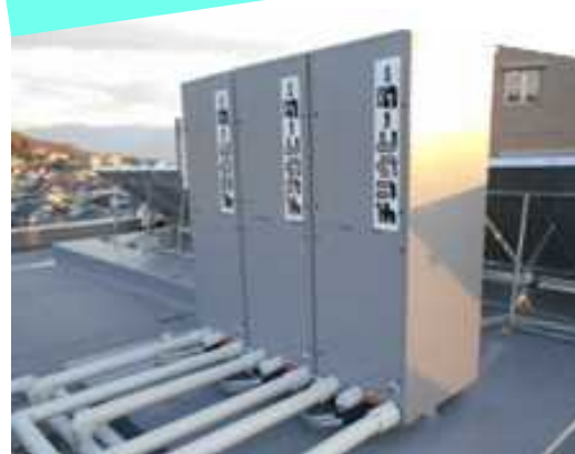
導入設備（貯水槽）
