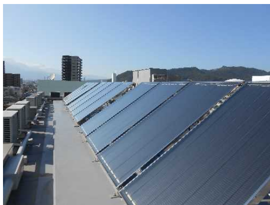
導入設備（集熱パネル）
