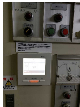
従来の制御盤に新設備の 操作盤を組み込み
