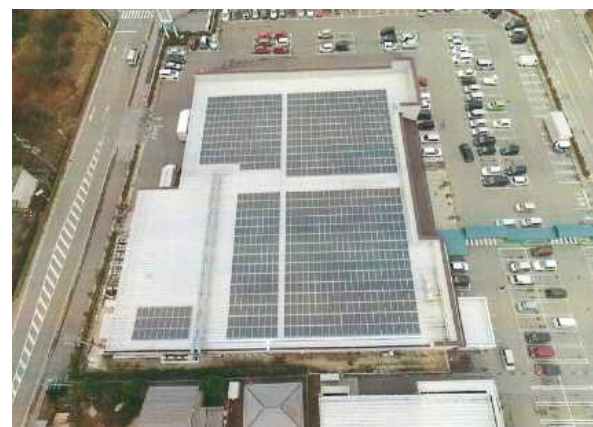
店舗屋上の太陽光パネル
