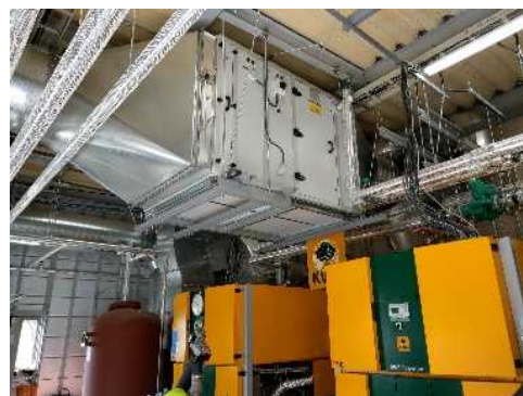
温風を作る空気調和機 (蓄熱タンクの熱をチップ乾燥に利用)
