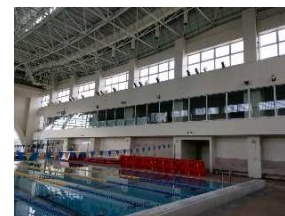
大洲温水プール
