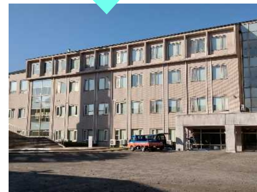
窓サッシの更新（補助外）
