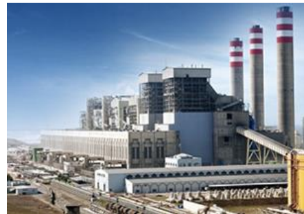
出典：IHI社HPより ジョルフ・ラスファール発電所
