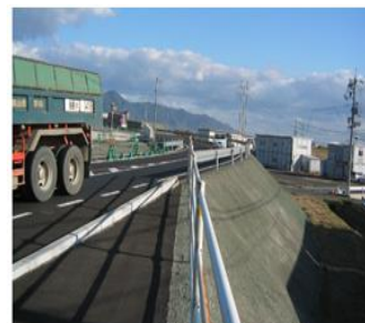
路盤材施工事例
