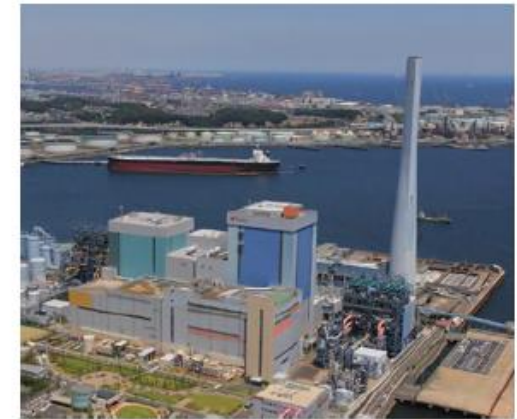
磯子火力発電所 (出典; 電源開発ホームページ)
