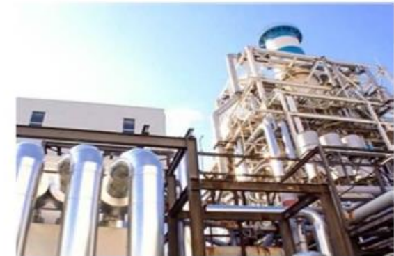
500MW級水素混焼試験設備（出典；MHPS）
