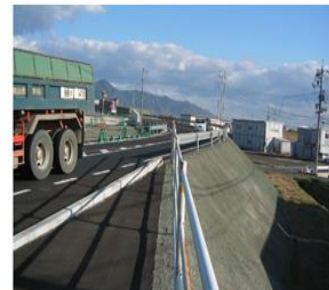
路盤材施工事例
