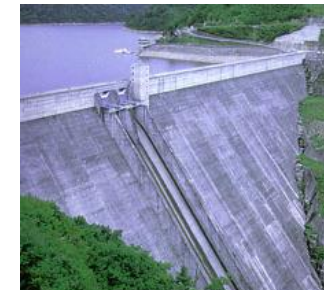
ダム建設での大量利用
