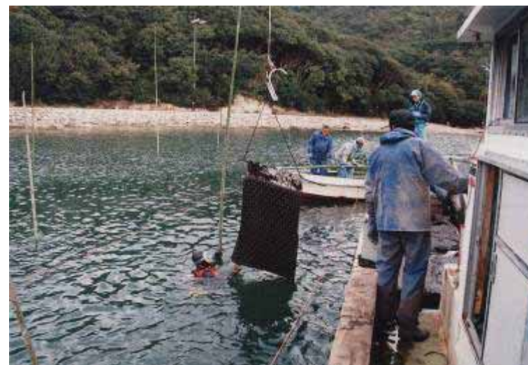
土のう式播種マットの敷設
