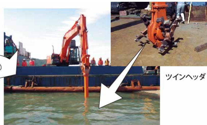
バックホウによるすき込み
