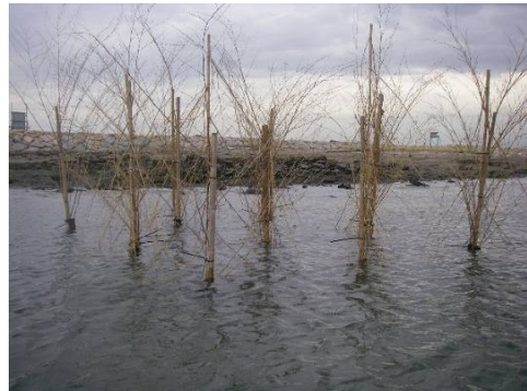
逆さ保全竹の設置状況
