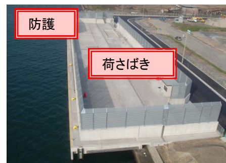
【循環資源取扱支援施設の例(北九州港)】
